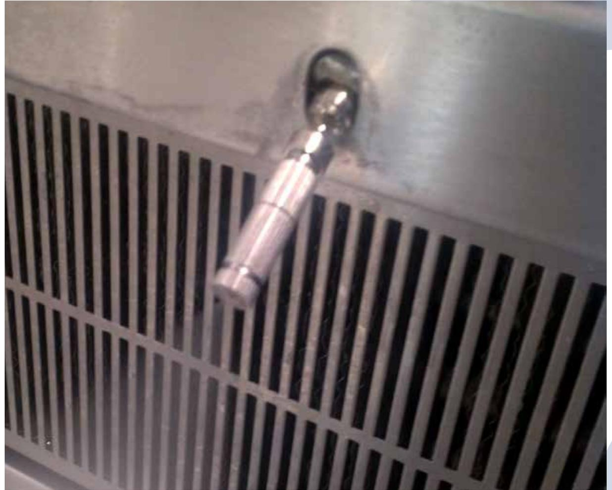
**I nostri sistemi utilizzano pompe ad alta pressione (70 bar), filtri antibatterici ed ugelli orientabili con fori da 0,15 mm.**
